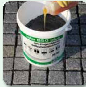
Bindemittelkomponente zugeben
